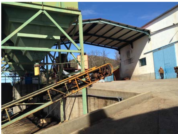
Instalaciones de la cooperativa.
